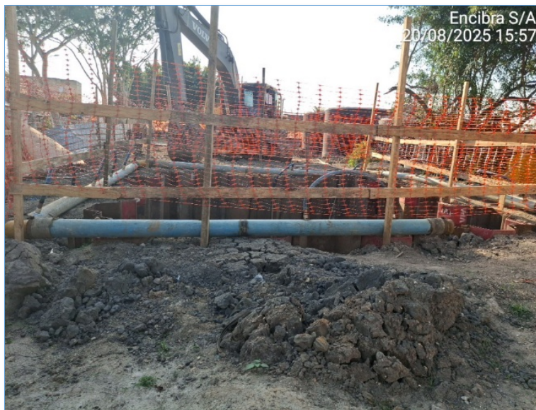
Execução da escavação para a Estação Elevatória CV 2.1, localizada na Sub-bacia CV02 - Sistema de Cação Vermelho (2025)
