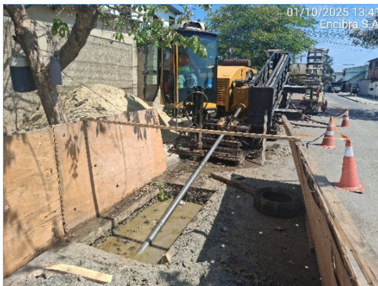
Implantação de rede de esgoto pelo método não destrutivo(MND) na sub-bacia CV05, no Sistema de Cação Vermelho (2025)
