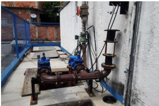
Readequação da elevatória
