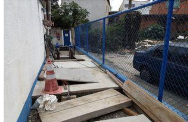
Readequação do poço de elevatória
