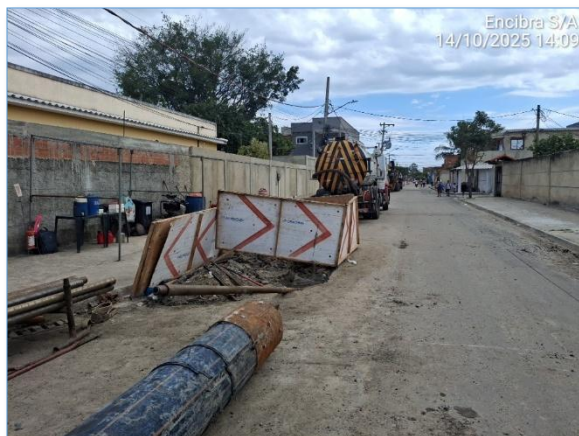
Implantação de rede de esgoto pelo método não destrutivo(MND) na sub-bacia CV05, no Sistema de Cação Vermelho
