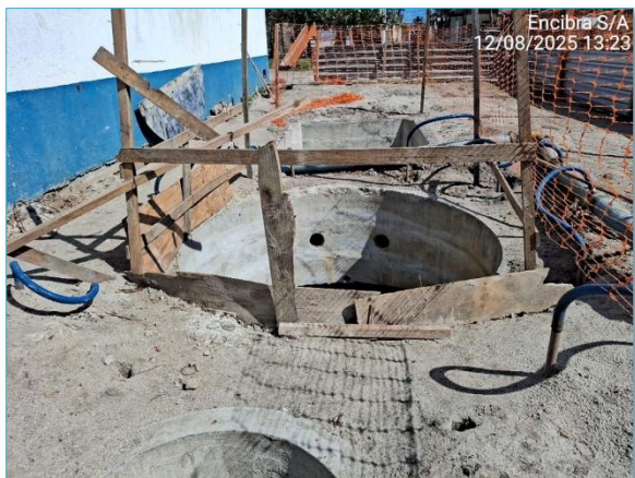
Execução da Estação Elevatória CV1.2, localizada na Sub-bacia CV01 – Sistema Cação Vermelho
