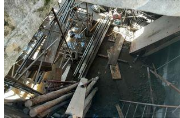
Obras de readequação no reator 1
