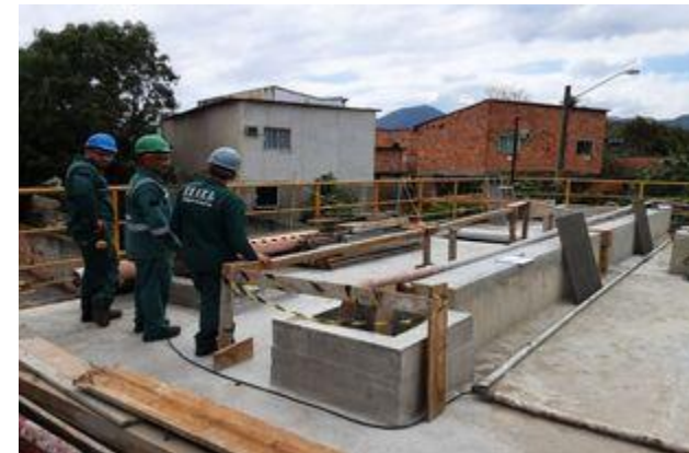
Obras de readequação no reator 1
