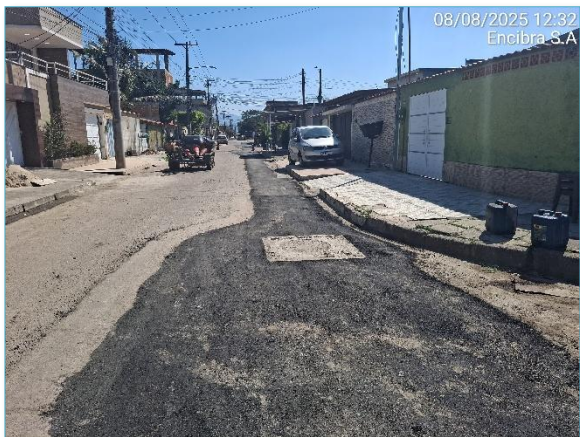
Execução de rede na sub-bacia CV03 – Sistema Cação Vermelho
