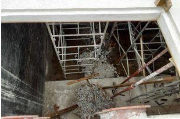
Readequação no reator 1
