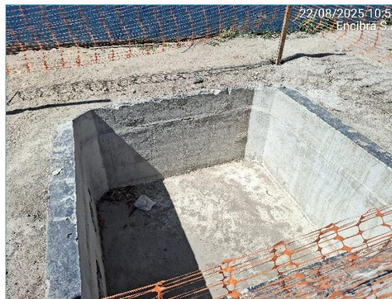
Execução da Estação Elevatória CV1.2, localizada na Sub-bacia CV01 – Sistema Cação Vermelho
