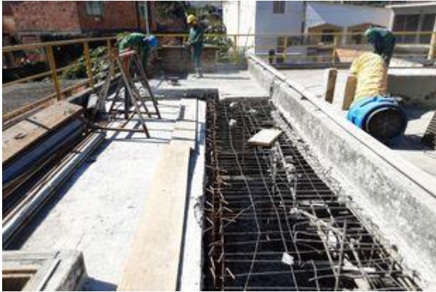
Obras de readequação no reator 1
