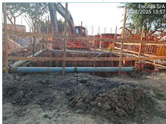
Execução da escavação para a Estação Elevatória CV 2.1, localizada na Sub-bacia CV02 - Sistema de Cação Vermelho
