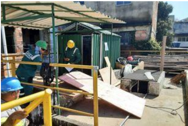
Obras de readequação no reator 1
