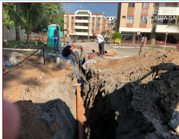
Execução de rede coletora - ANO 2021 Sub Bacia MG 14 (Sistema Marangá)
