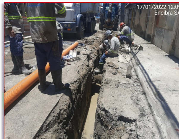
Execução de rede coletora - ANO 2022 Sub Bacia SR 04 (Sistema SarapuÍ)
