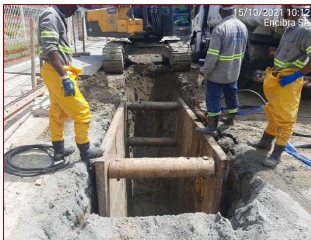
Execução de rede coletora - ANO 2021 Sub Bacia SR 8 (Sistema SarapuÍ)
