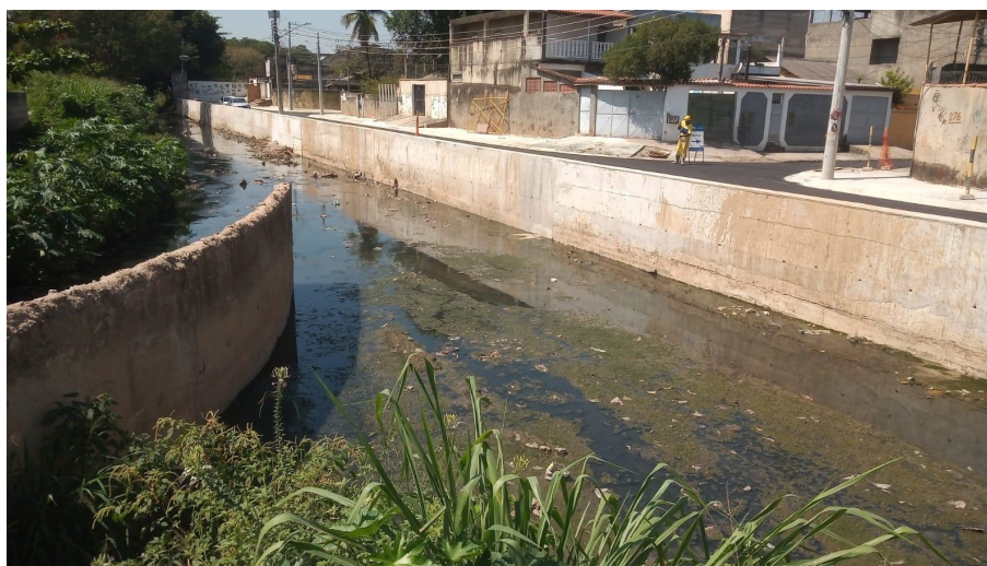
Foto 3: Obra de emergência no Rio Pavuna, no bairro da Pavuna
