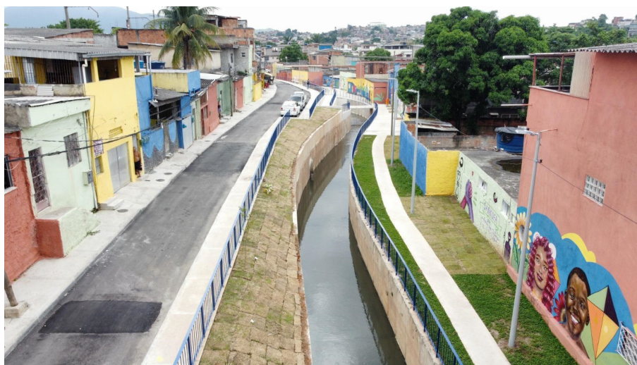
Foto 1: Obra contra enchentes realizada no Canal da Rua Comendador Guerra, no bairro da Pavuna
