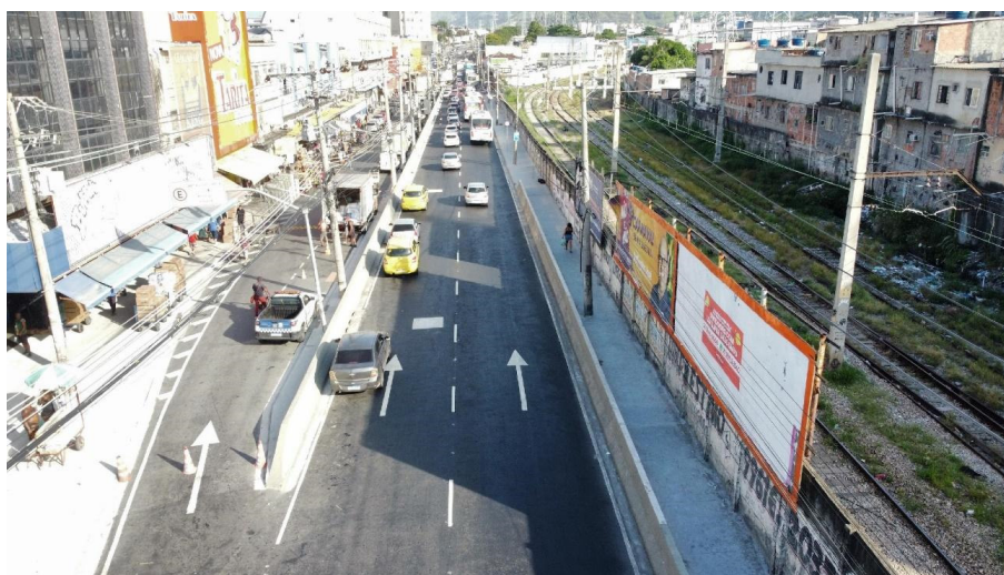
Foto 4: Obras de drenagem concluída no entorno do Mercado de Madureira
