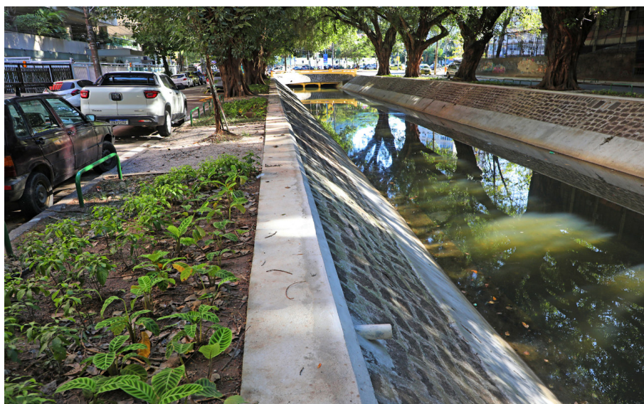
Foto 6: Conclusão da obra de recuperação do Canal da Av. Visconde de Albuquerque
