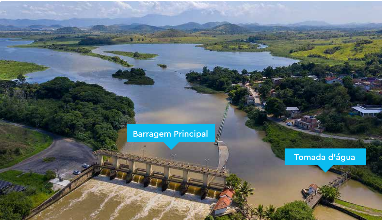
Figura 12. Estruturas de captação – Sistema Guandu
