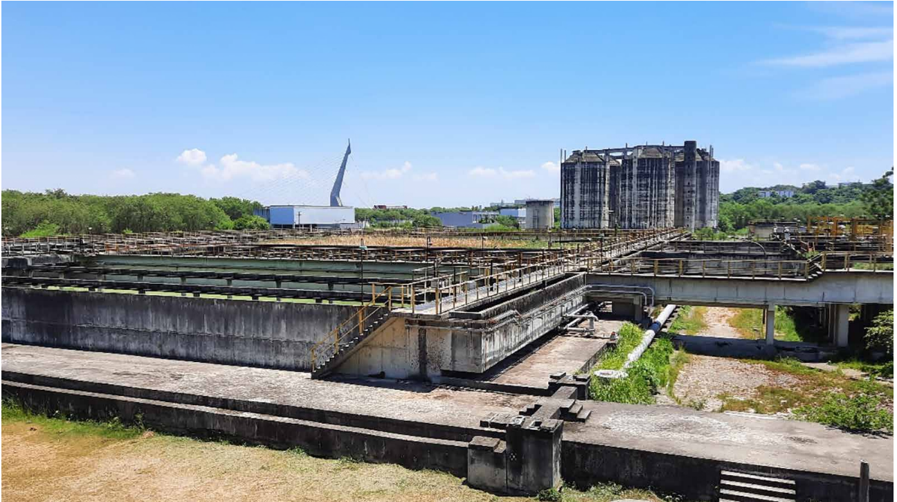
Figura 38. Visita à ETE Alegria
