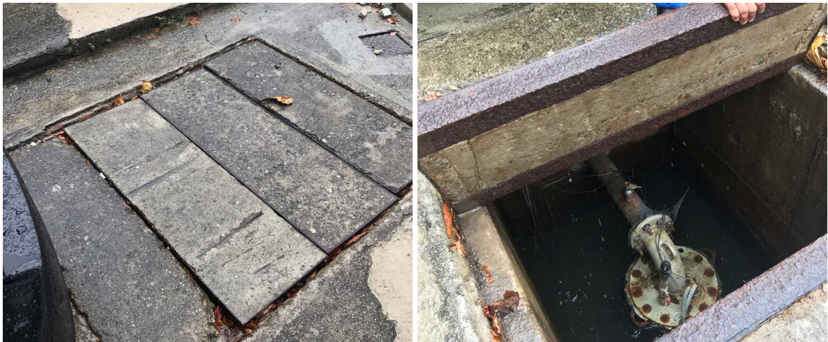
Figura 30. EEAT do tipo submersa
