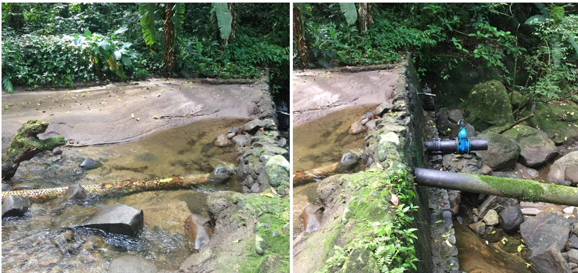
Figura 26. Barragem de acumulação e tubulação de captação – Captação Rio Sacarrão
