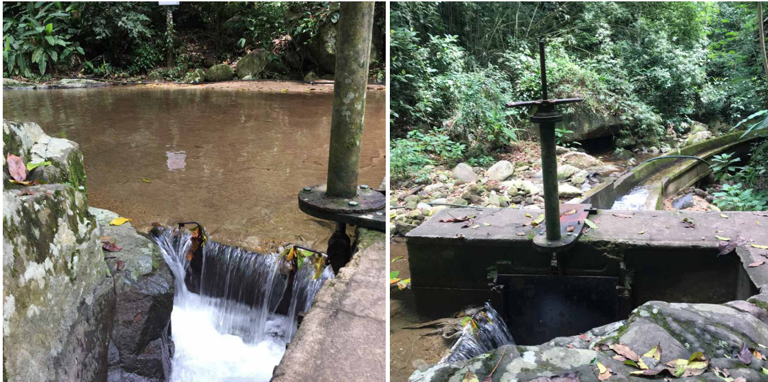
Figura 25. Barragem de acumulação e canal de adução – Captação Rio Grande
