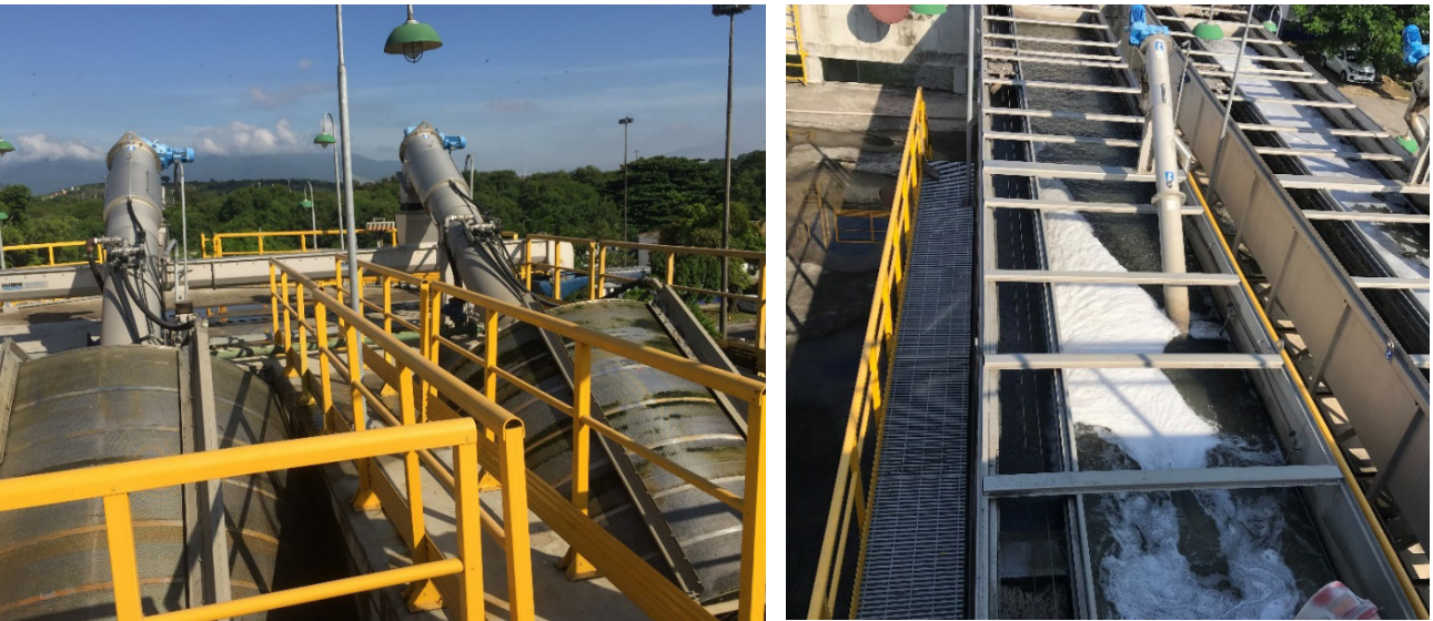
Figura 39. Visita à ETE Deodoro
