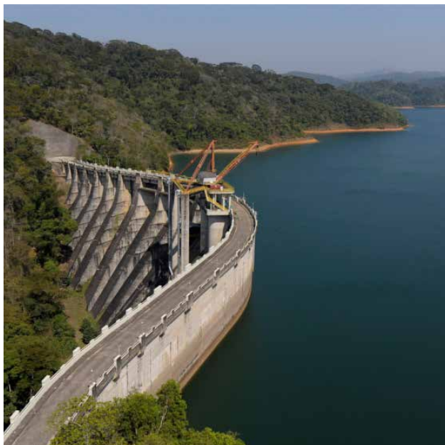
Figura 17. Reservatório de Lajes
