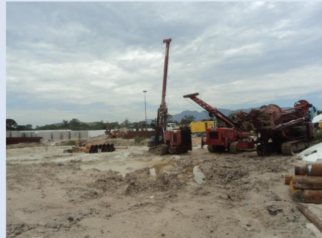
Cravação de estacas para o tanque biológico (ETE Deodoro)
