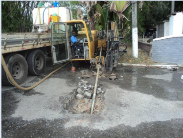
Execução de rede coletora pelo Método Não Destrutivo (MND)
