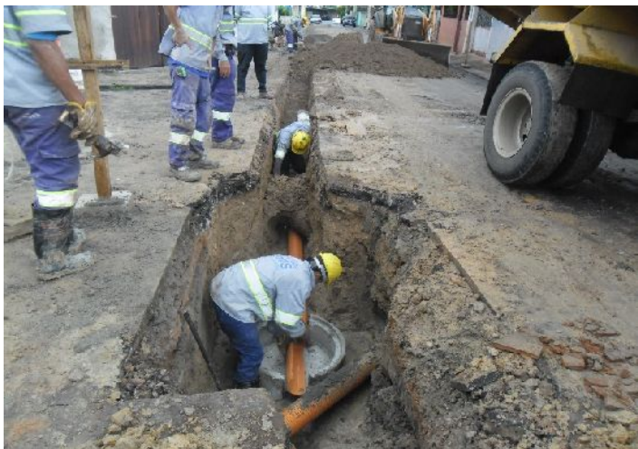
Figura 24: Assentamento de rede coletora de esgoto sanitário (Vistoria Contrato de Apoio)
