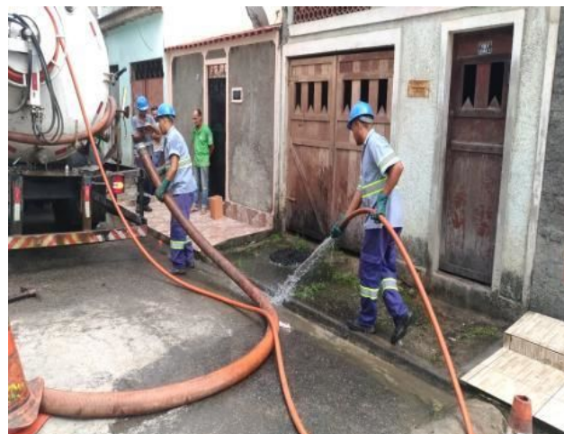
Figura 30: Desobstrução de rede coletora de esgoto sanitário (Vistoria Contrato de Apoio)
