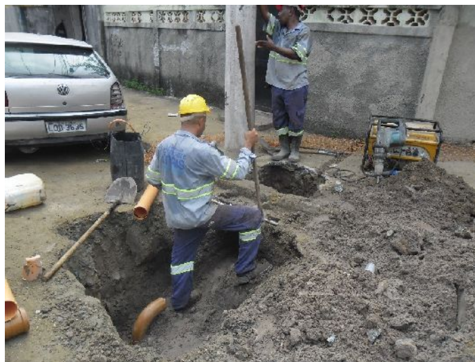
Figura 26: Implantação de ramal de ligação predial (Vistoria Contrato de Apoio)
