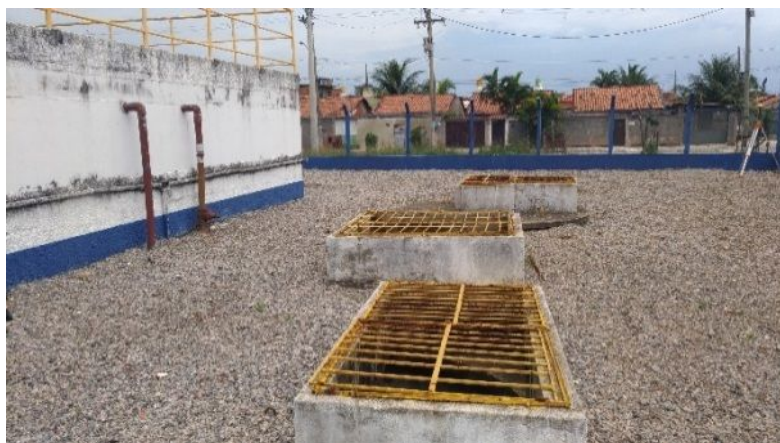
Figura 34: ETE Nova Sepetiba V (Vistoria Contrato de Apoio)
