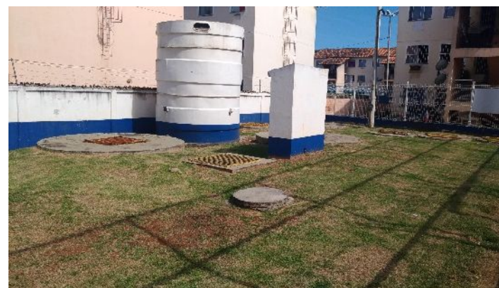
Figura 41: ETE Condomínio Trento (Vistoria Contrato de Apoio)
