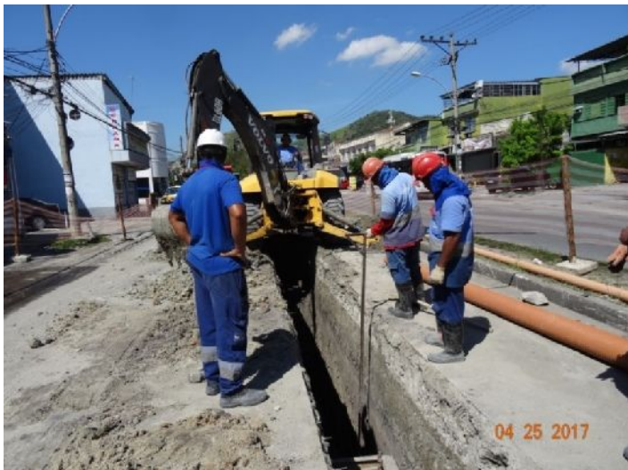
Figura 23: Assentamento de rede coletora de esgoto sanitário (Vistoria DIS/GFT)
