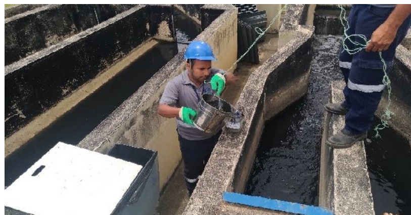
Figura 36: ETE Pedra de Guaratiba (Vistoria Contrato de Apoio)
