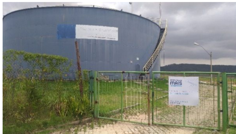
Figura 35: ETE Pedra de Guaratiba (Vistoria Contrato de Apoio)
