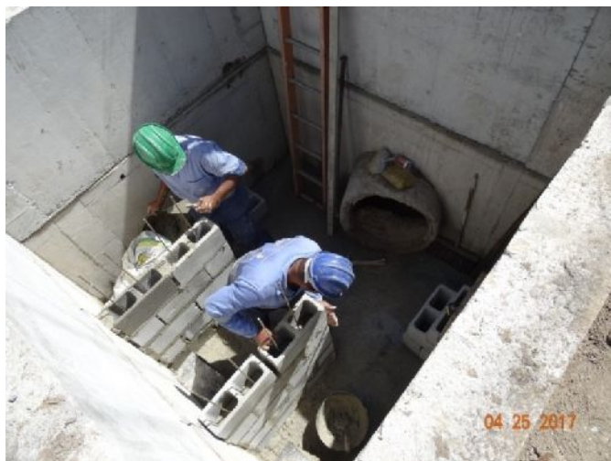
Figura 27: Execução de sifão invertido (Vistoria DIS/GFT)
