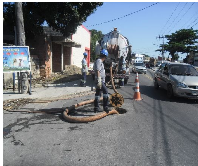
Figura 29: Desobstrução de rede coletora de esgoto sanitário (Vistoria Contrato de Apoio)
