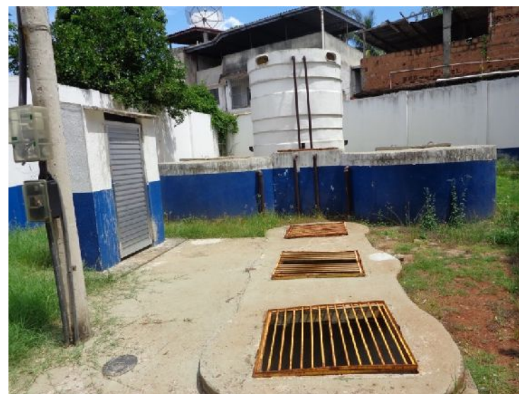
Figura 40: ETE Condomínio Oiti (Vistoria DIS/GFT)
