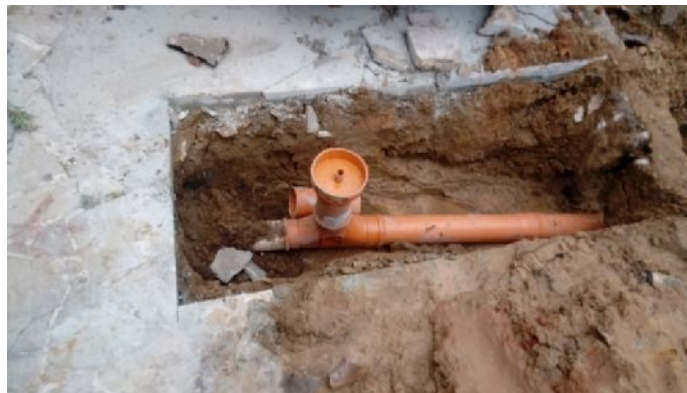
Figura 25: Implantação de ramal de ligação predial (Vistoria DIS/GFT)
