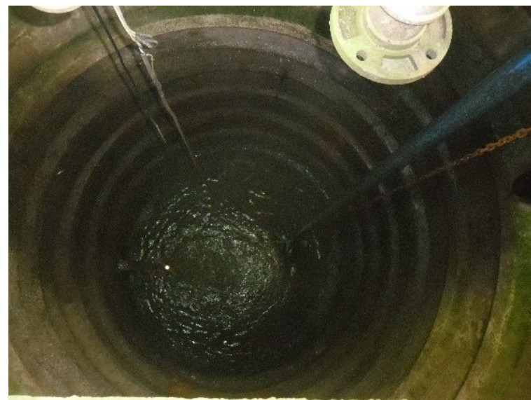
Figura 39: ETE Nova Sepetiba IV (Vistoria Contrato de Apoio)
