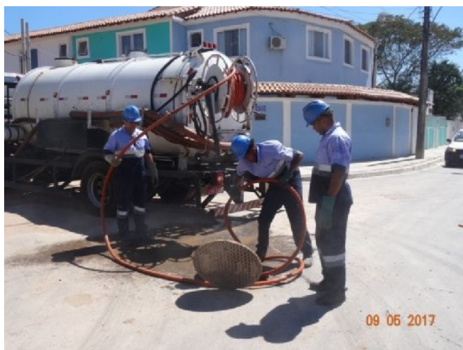
Figura 28: Desobstrução de rede coletora de esgoto sanitário (Vistoria DIS/GFT)
