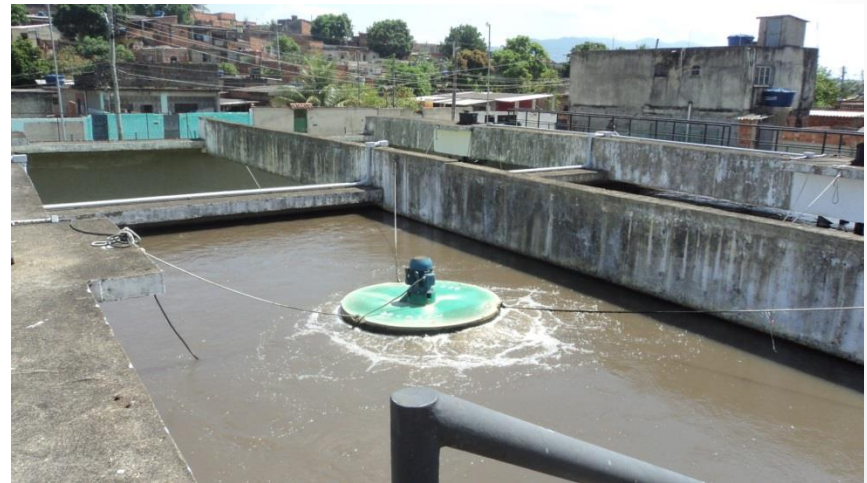
Vistoria ETE Nova Cidade (ativa)
