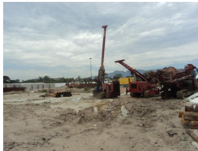
Cravação de estacas para o tanque biológico (ETE Deodoro)
