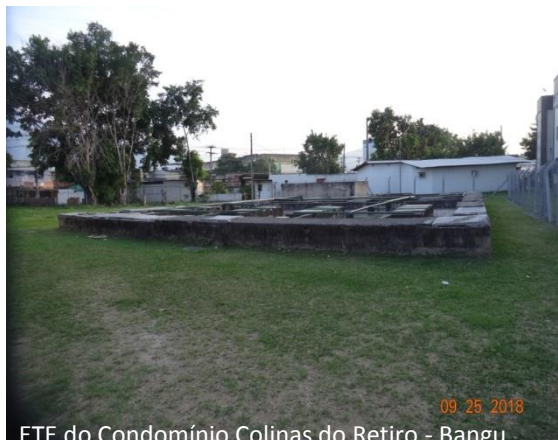
ETE do Condomínio Colinas do Retiro - Bangu
