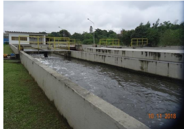
ETE Palmares – Valo de oxidação
