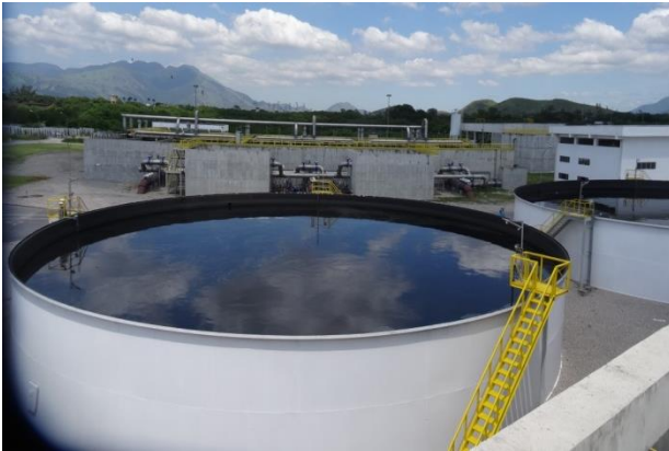
ETE Deodoro – Tanque de equalização
