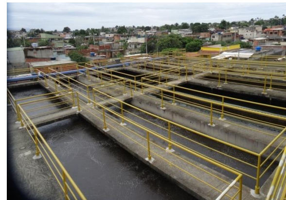
ETE Sepetiba – Tanque
