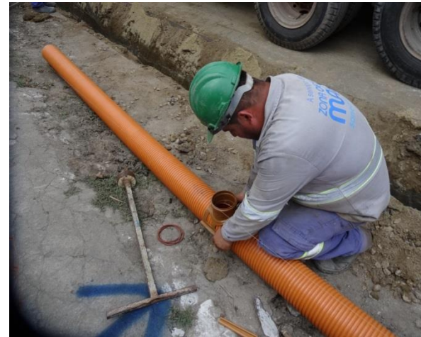
Execução de rede e ligação predial Sub Bacia SR 2 (Sistema Sarapuí)
