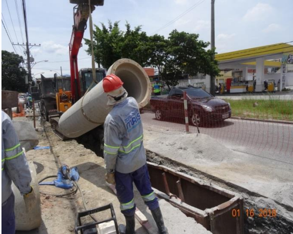
Execução de coletor tronco Sub Bacia MG 12 (Sistema Marangá)
