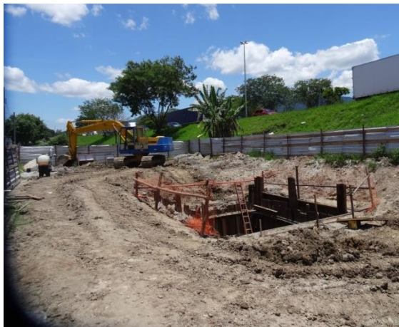
Execução de elevatória Sub Bacia GC 2 (Sistema Marangá)
